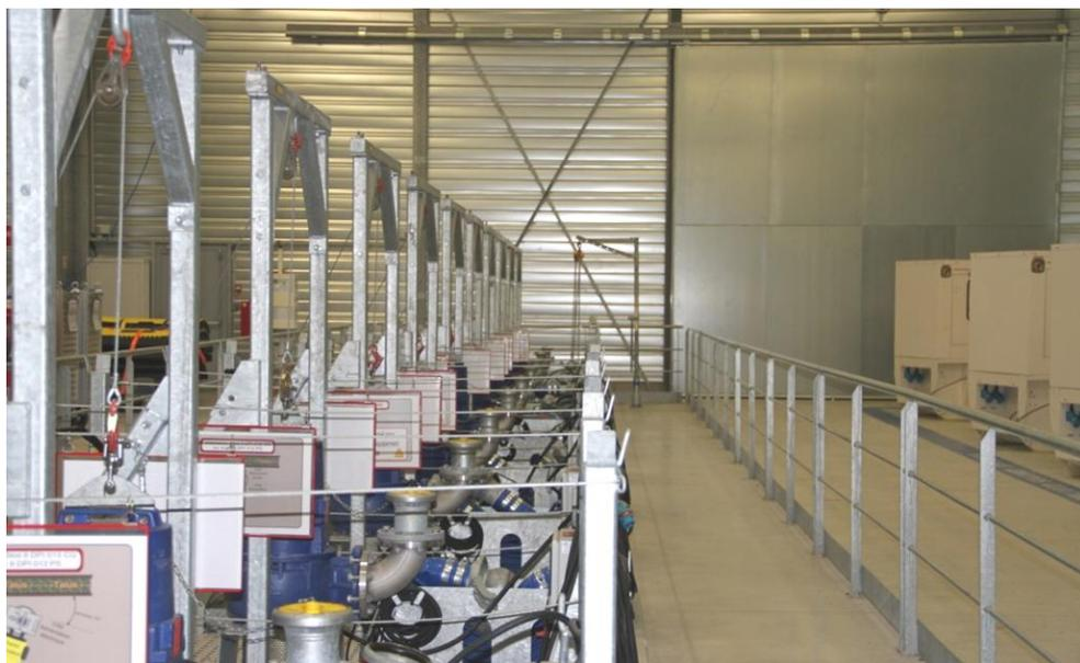
Bâtiment PUI regroupant des matériels mobiles de sûreté (pompes, groupes électrogènes,...)
